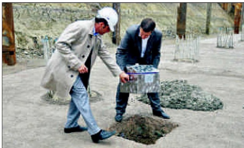
Die Bauherrschaft setzt die Kiste ins Fundament des «Hard Turm Park». (12. 5. 2011)
